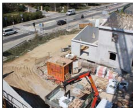
Le plus gros chantier en cours...
