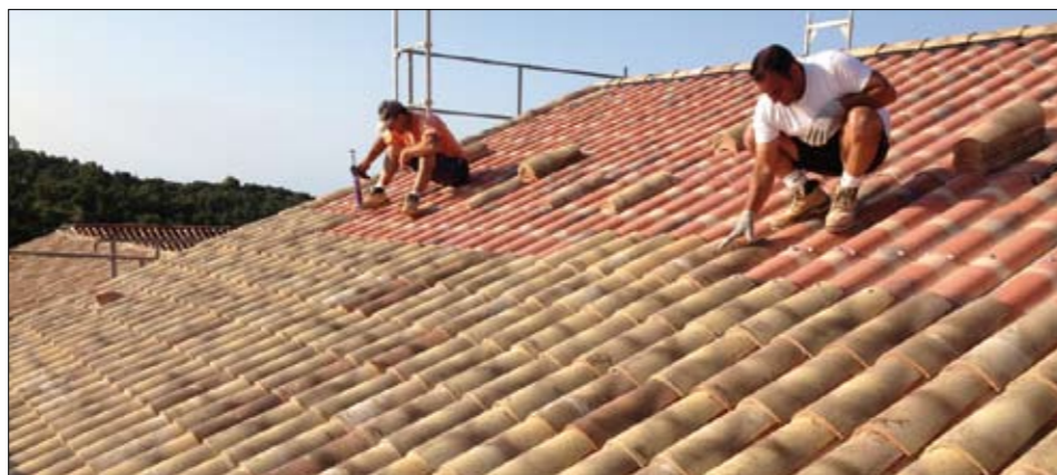
Avant/ après. Une toiture neuve réalisée durant l'été
