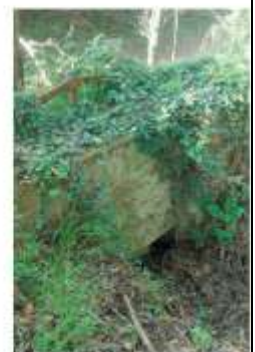
Ouvrage hydraulique sur le Bourrian
