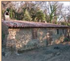
La bergerie rénovée
