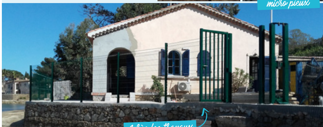
Après les travaux
