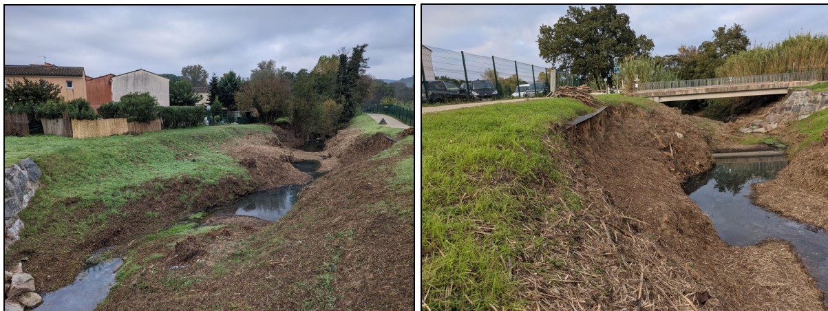
Des travaux entrepris en 2020 qui ont totalement fauchés la strate arbustive (projet de piste cyclable)
