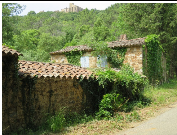
12. Bâtisses parcelles A 912 et 913, lieudit Tras Barri
