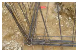
Nœud de chaînage - Continuité mécanique
