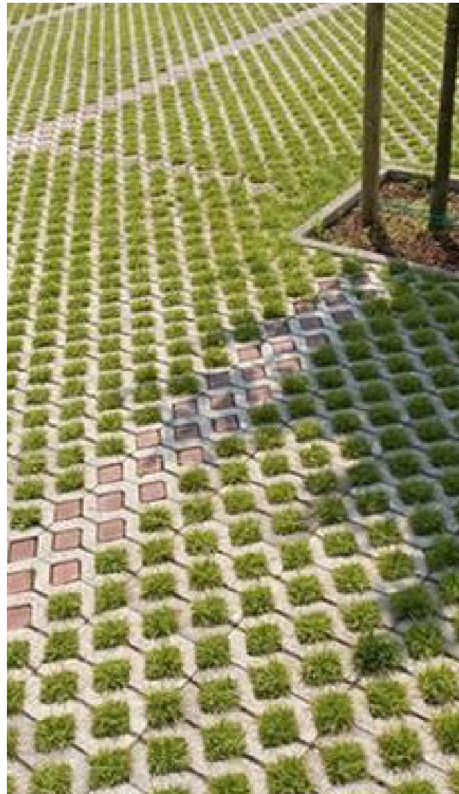
Pavés enherbés pour moins d'imperméabilisation des sols
