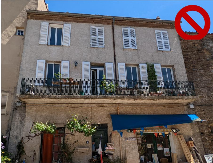
La pose de baies coulissantes en aluminium et plus généralement la suppression des petits bois (carreaux) appauvrit la façade déjà profondément altérée par la mise en oeuvre d'un enduit de finition rustique au ciment et la suppression des éléments de décors. Seuls la corniche et le garde-corps en fonte nous donnent des indications sur la qualité de cette belle façade remaniée au 19<sup>e</sup>.
