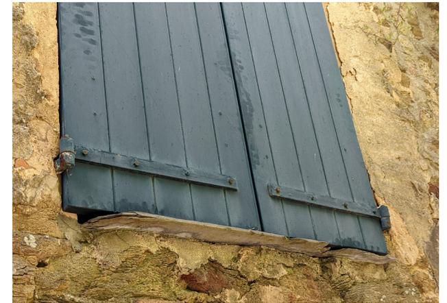
Très souvent, une feuille d'ardoise vient en couverture des appuis de fenêtres. Ce principe d'appuis devra être conservé voire restitué. Les appuis en terre cuite ou carrelage sont à exclure.
