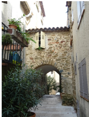
4. Passage sous bâti, parcelle D 144, le village
