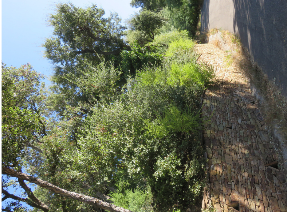
Haie libre offrant une diversité de végétaux sur muret en pierres sèches de Bormes (absence de joints maçonnés)
